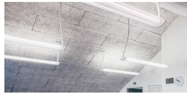
AKUSTICKÁ IZOLACE HERAKLITH C FACADE AK01 TL.25 mm 600x2000 hmotnost 10,5 kg/m 2
