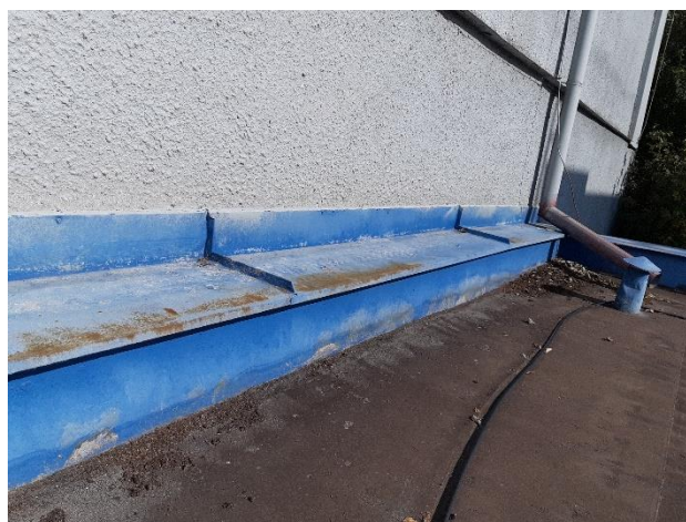
↑Detail oplechování stávající atiky kotelny
