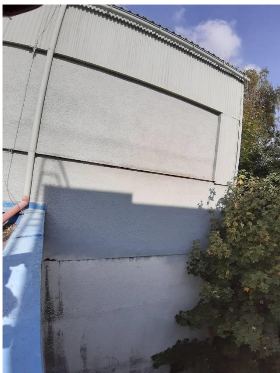
↑Detail oplechování stávající atiky kotelny
