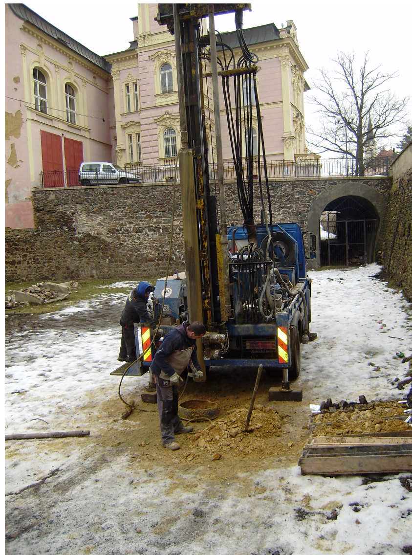
Obr. 4: Realizace průzkumného vrtu S2 (s pracovním označením K2).
