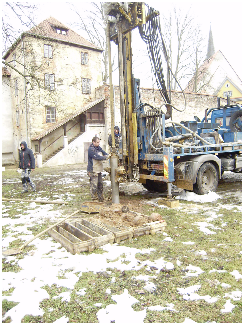
Obr. 3: Realizace průzkumného vrtu S1 (s pracovním označením K1).
