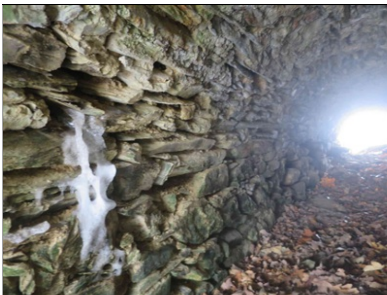
pohled na líc opěry
