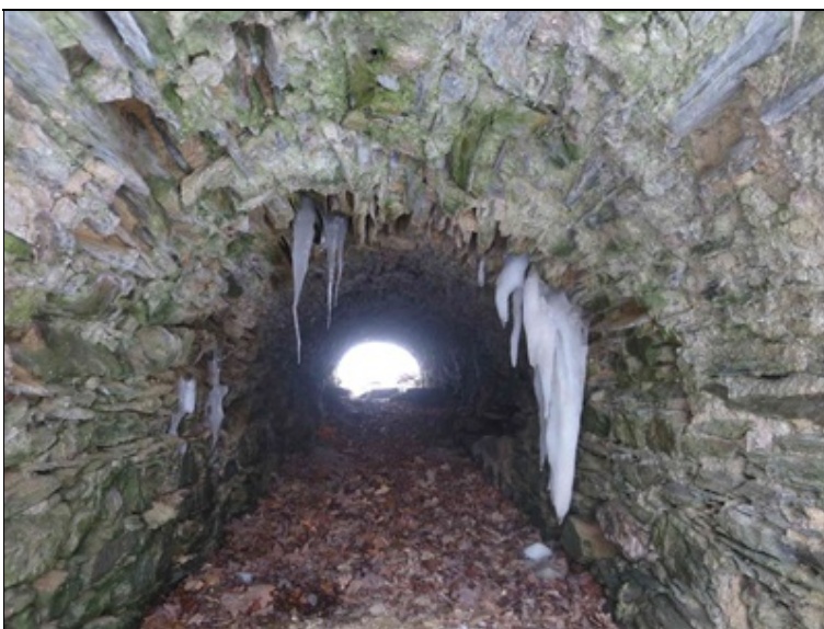
průhled mostním otvorem
