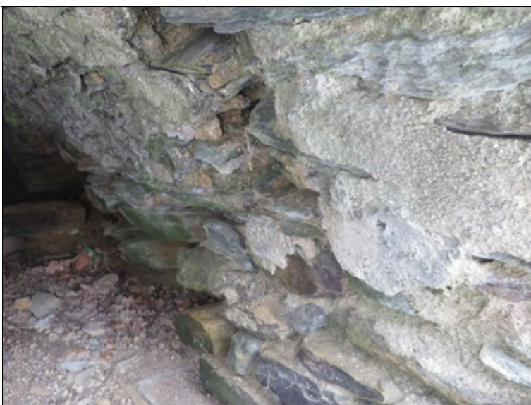
rozpad zdiva v patě klenbového pasu
