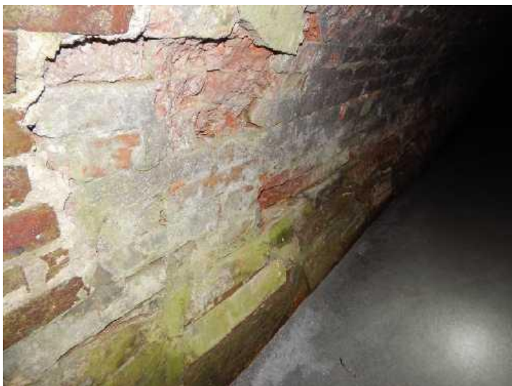
Degradace konstrukce. cihelného zdiva nosné
