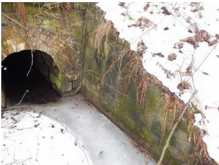
Vegetace uchycená na boku betonového křídla.
