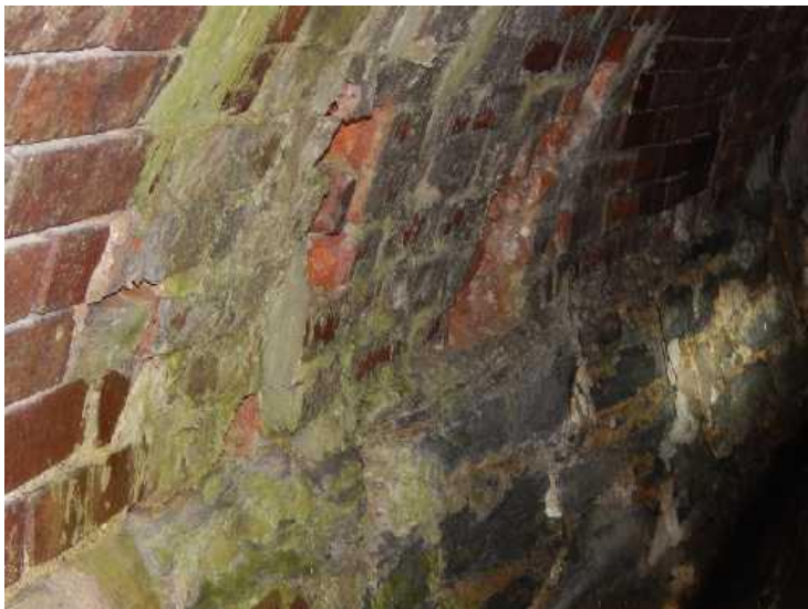
Degradace konstrukce. cihelného zdiva nosné
