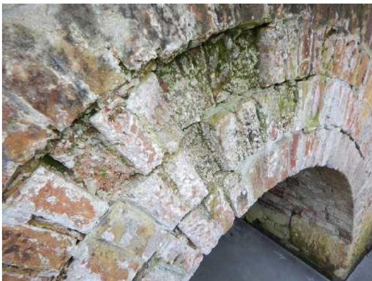
Rozpad cihelného zdiva na pravé straně.
