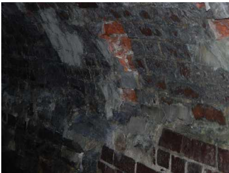
Degradace cihelného zdiva nosné konstrukce.
