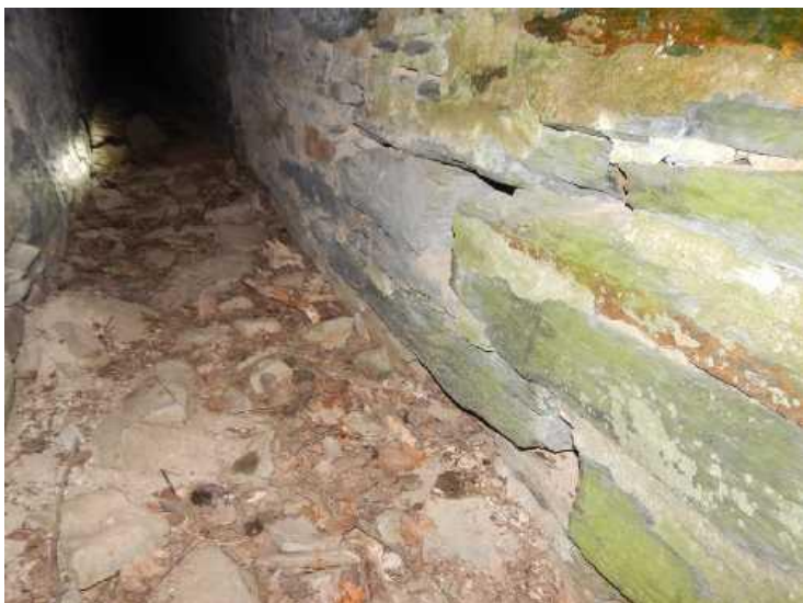
Hlubkově vyplavené spárování, rozvolněné zdivo opěry OP1 - střední část.
