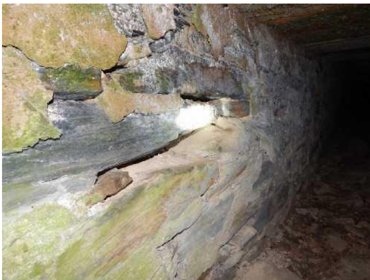
Vypadlý kámen z dříku opěry OP2 - střední část.
