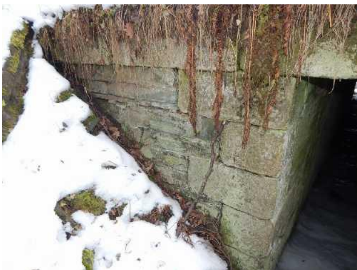
Levé křídlo u opěry OP2. Hlubkově vyplavené spárování. Vegetace v okolí propustky.
