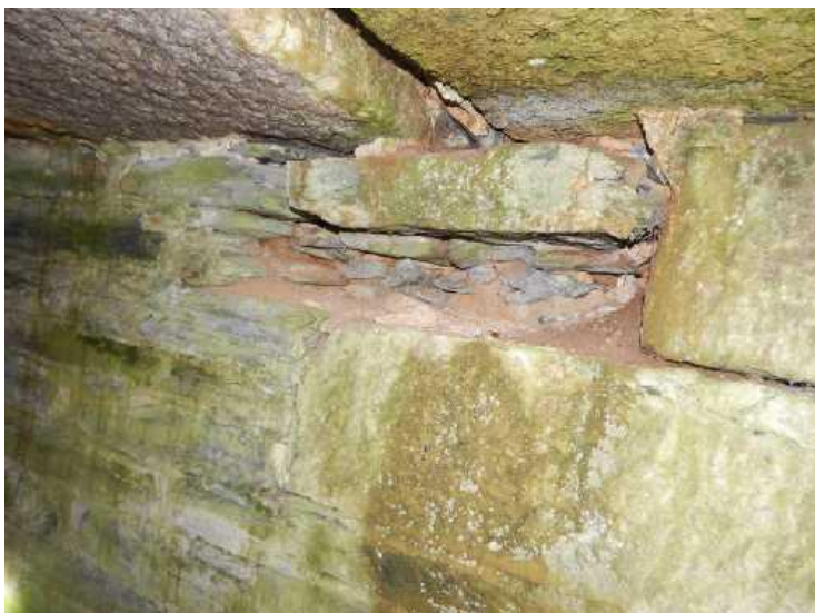
Detail vypadlého kamene úložného prahu opěry OP1 na levé straně.
