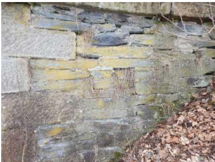
Pohled na pravé křídlo opěry OP2, spárování je vyplavené, ve sparách uchycena vegetace.
