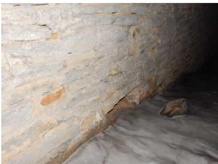
Detail vypadlého kamene v patě opěry OP2 ve střední části.
