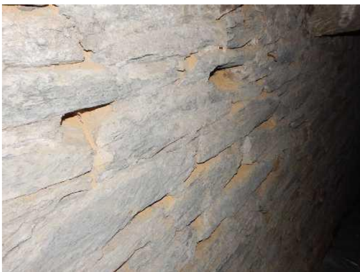
Hlubkově vyplavené spárování zdiva opěry OP2 na pravé části.
