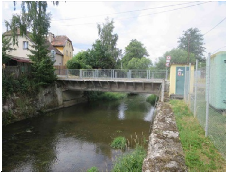
pohled na levou stranu mostu
