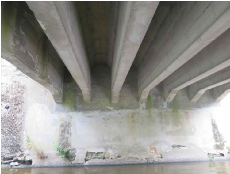
podhled NK směrem k O1
