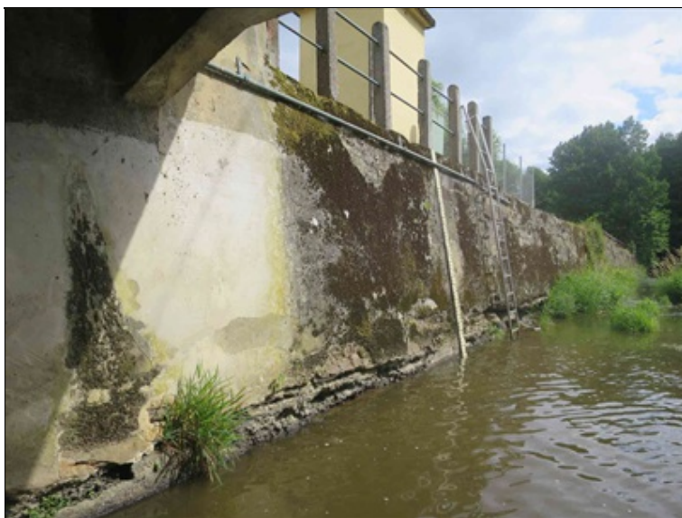
podemletá levá zeď navazující na opěru 1
