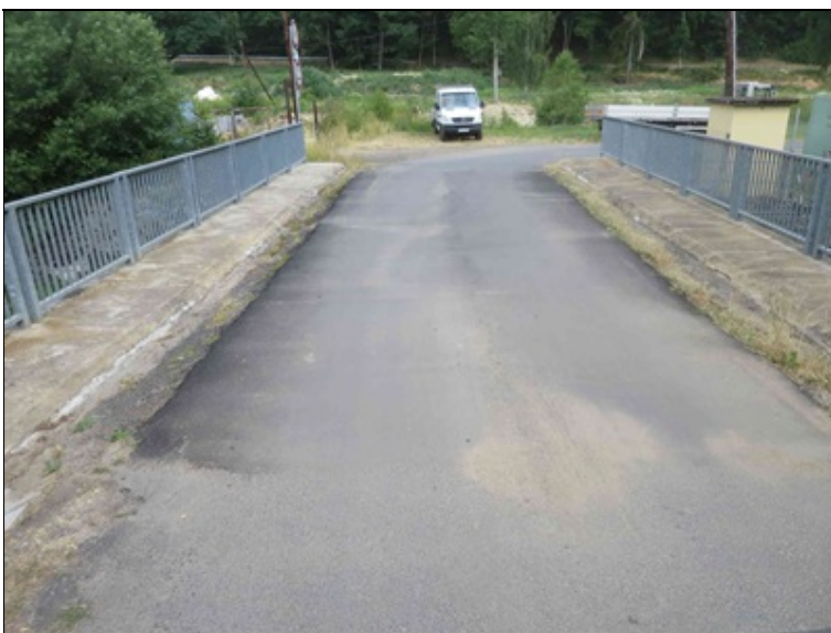
pohled na vozovku
