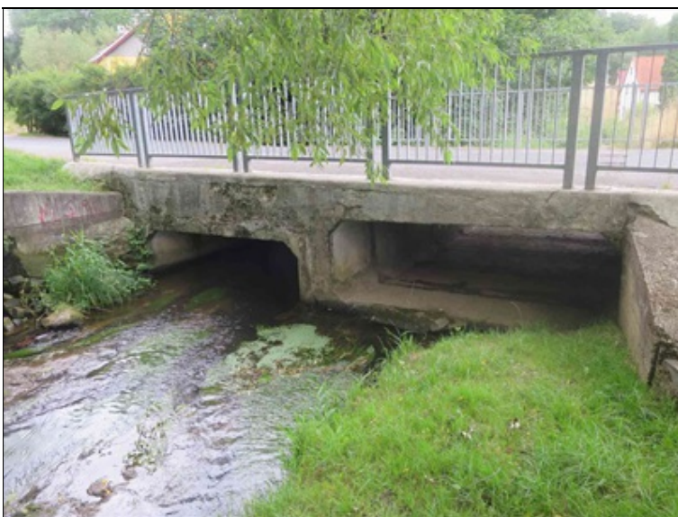
pravý bok mostu
