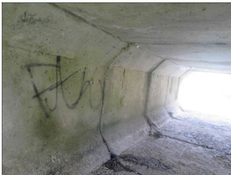
pohled na stěnu rámu v 2. (inundačním) poli
