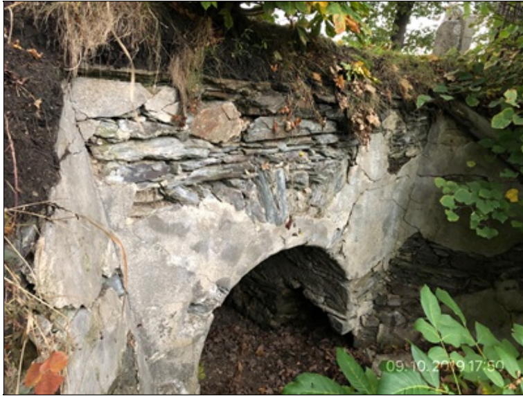
4-pohled na čelní zeď.jpg
