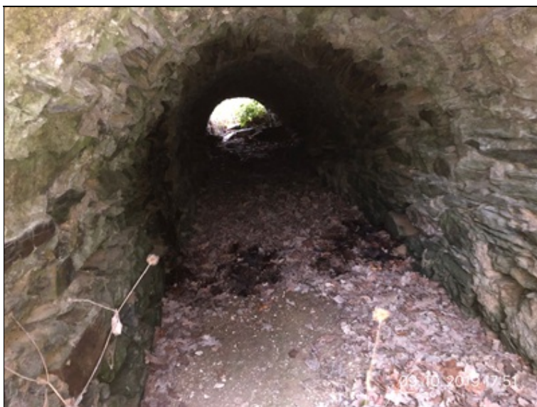
6-průhled mostním otvorem.jpg
