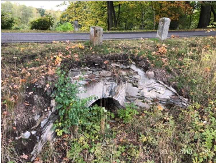
2-pohled na čelní zeď.jpg
