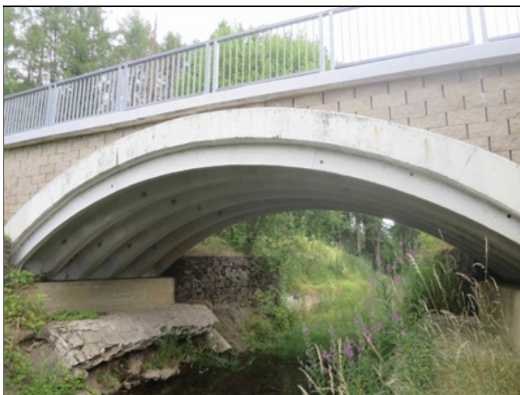
pohled na pravou stranu mostu
