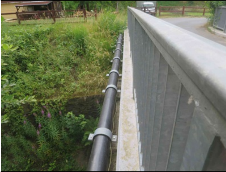
zavěšené vodovodní potrubí podél levé římsy
