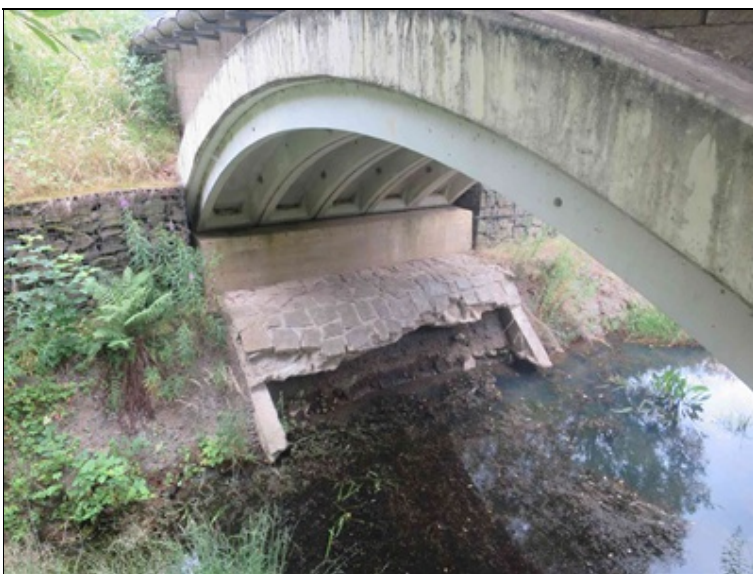
podemleté zpevnění svahu pod O2 - celkový pohled
