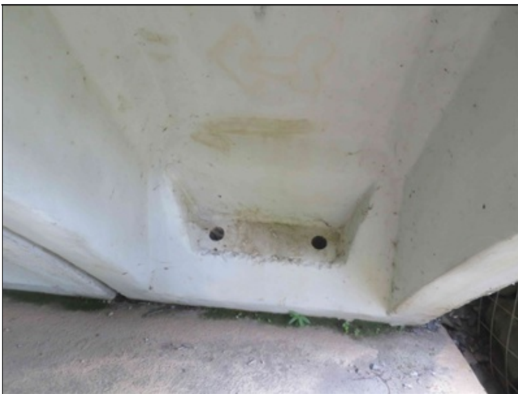
uložení prefabrikátů na opěru
