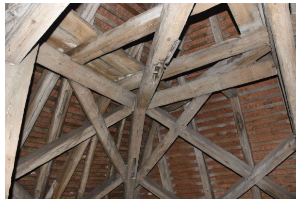
5. SEVERNÍ DIAGONÁLNÍ VAZBA SEVEROVÝCHODNÍ VALBY
