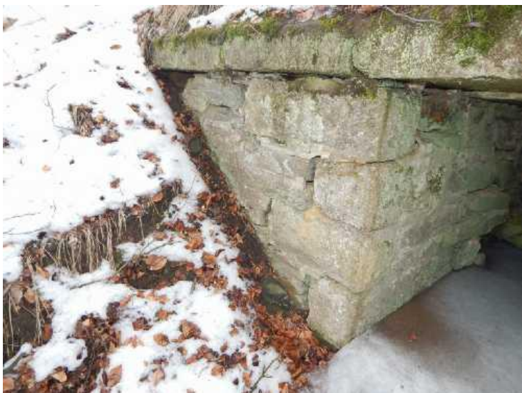
Rozvolněné zdivo na pravém rohu opěry OP1, zdivo se deformuje.
