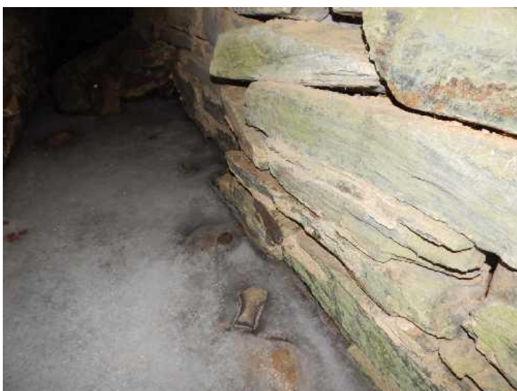
Detail rozpadajícího se zdiva dřívku opěry OP2. Zdivo je výrazně deformované.
