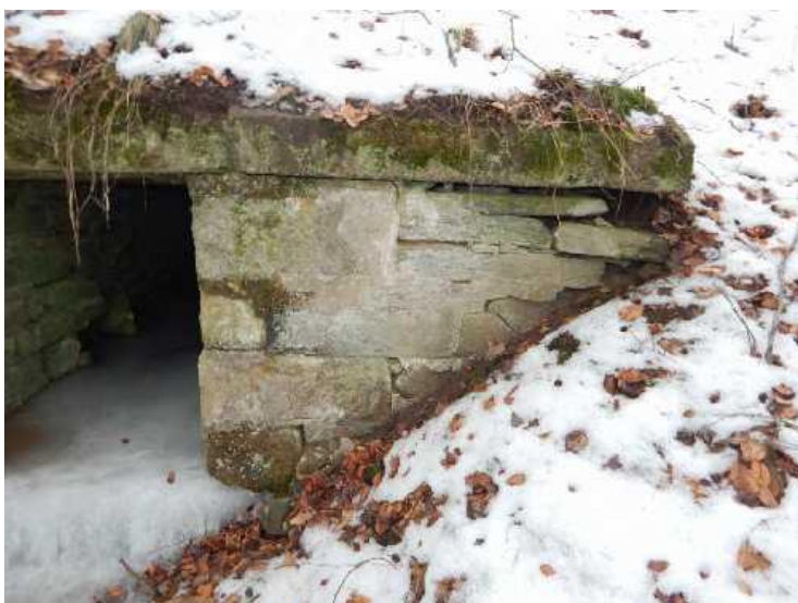
Detail rozpadu konce pravého křídla u opěry OP2.
