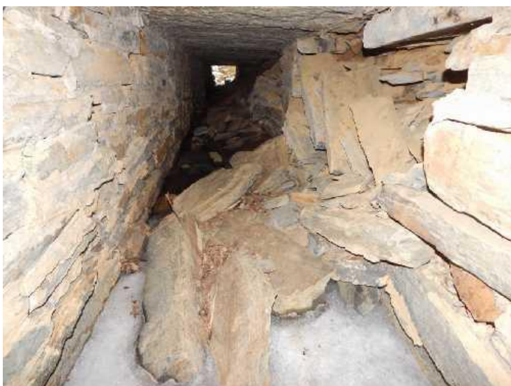
Zřícené zdivo opěry OP2 ve střední části.
