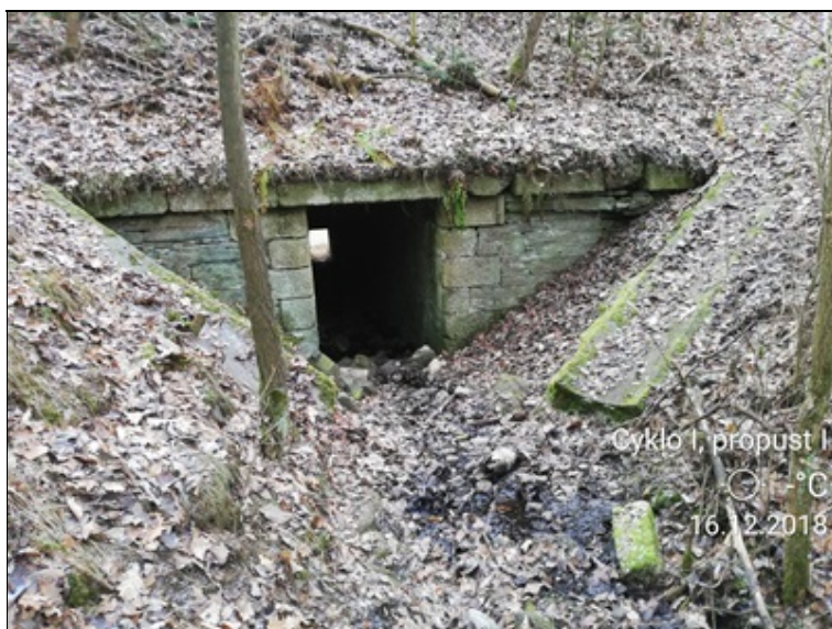
3 - zanesené koryto náletové dřeviny zanesená římsa.jpg
