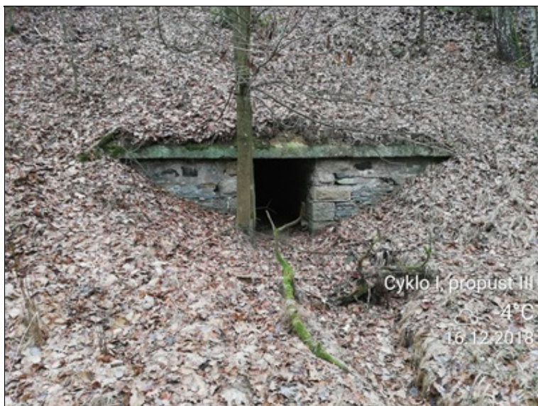
4 - pravé čelo propustku nežádoucí vegetace zanesené koryto degradace spár a zdiva.jpg
