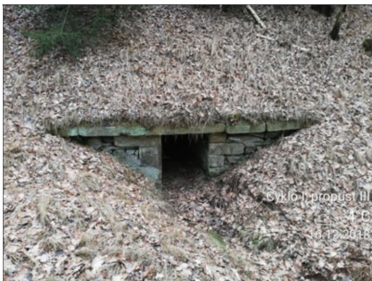
2 - čelo propustku degradace spár a zdiva zanesená římsa naplaveniny v korytě.jpg
