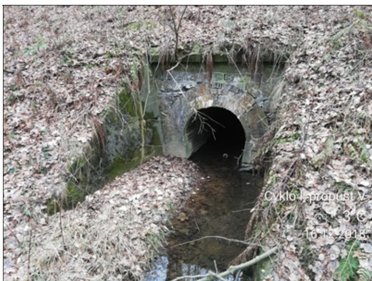
5 - nežádoucí vegetace na římse naplaveniny degradace cihelného.jpg
