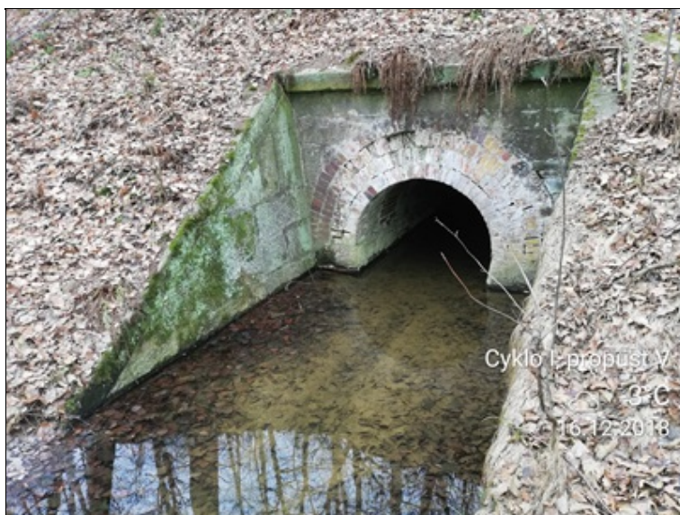
2 - pohled na čelo pravého propustku zanesená římsa a křídla naplaveniny v korytě degradace cihelného zdiva.jpg
