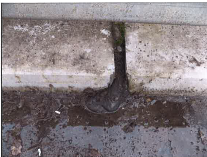
Vyteká zálivka MZ v pravé římse.
