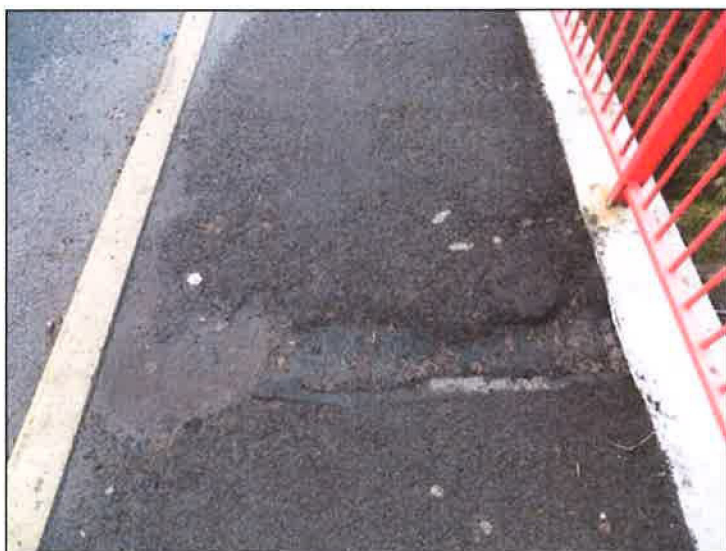
Detail rozpadu krytu.
