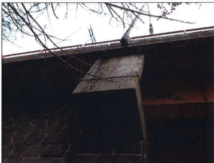
Zatékání na plentovací zídku O2.
