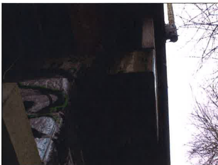
Detail zatékání na úložný práh.
