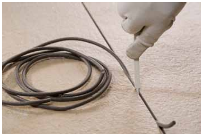
Obr. 18 – Separační provazec
