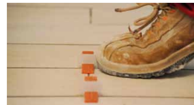
Obr. 8 – Odstranění spon
