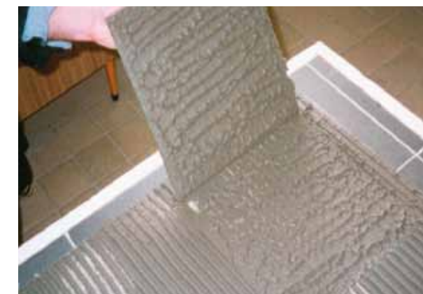
Obr. 10 – Lepení metodou Battering-Floating
