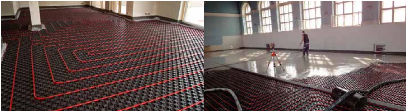
Obr. 13 – Příklad provedení podlahového vytápění – mokrý způsob
