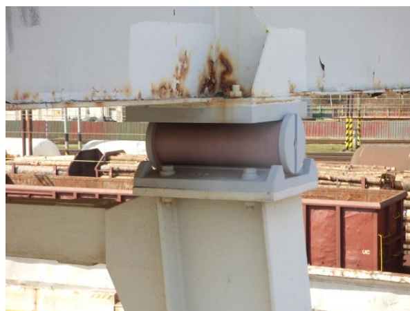
Obr.6 Válcové ložisko
