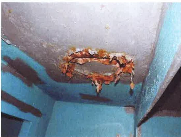
2. východní část NK - otvor v horním plechu komorového průřezu
