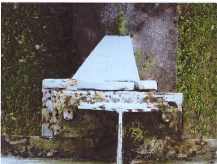
2. východní část NK - uložení NK na pilíř
