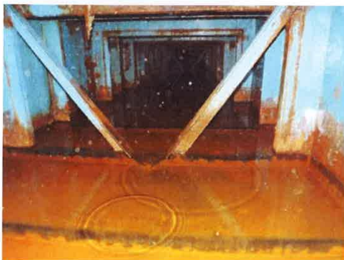
2. východní část NK - zatopená část komorového průřezu
