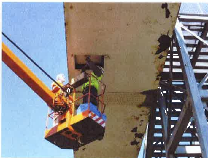
vstup do komory byl zajištěn pomocí vysokozdvížené plošiny
