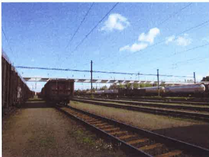
celkový pohled na lávku
