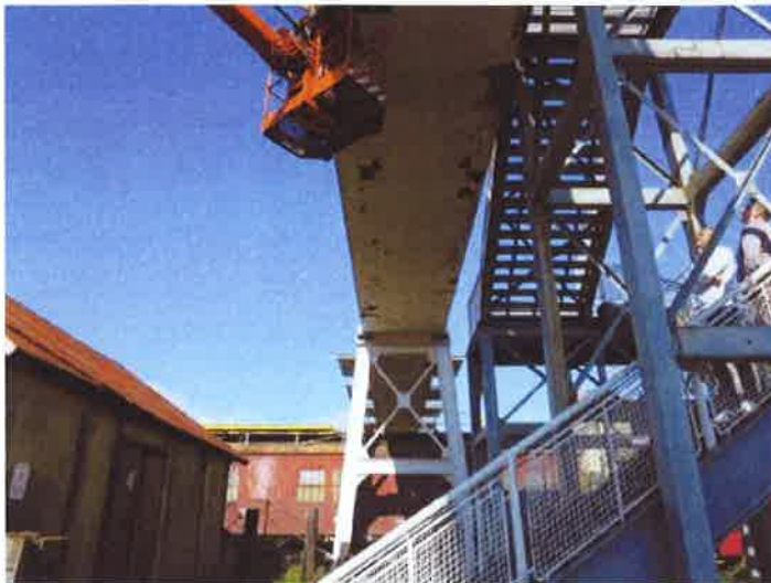
2. východní část NK - pohled směr západ
