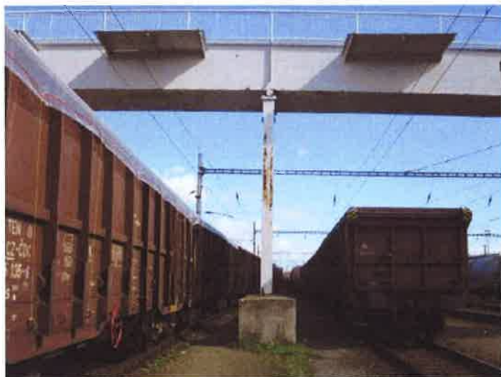
2. východní část NK - pohled na pilíř
