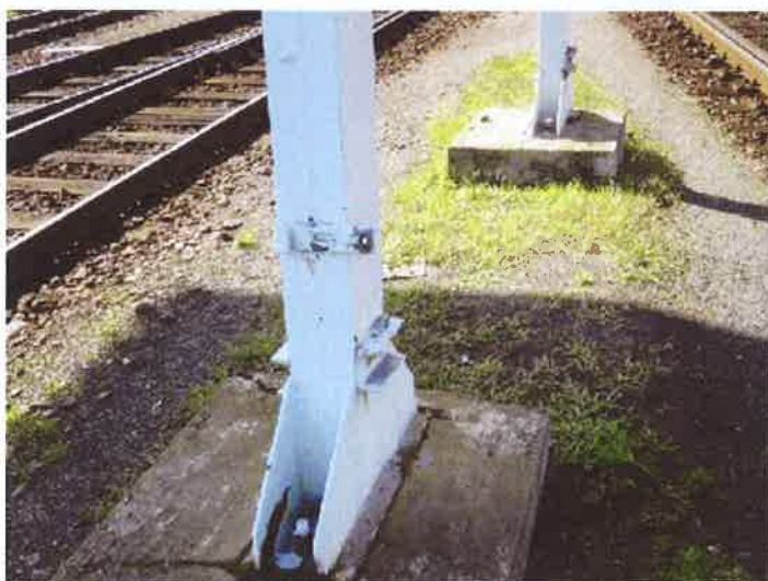
1. západní část NK - detail ukotvení kyvné stojky pilíře
