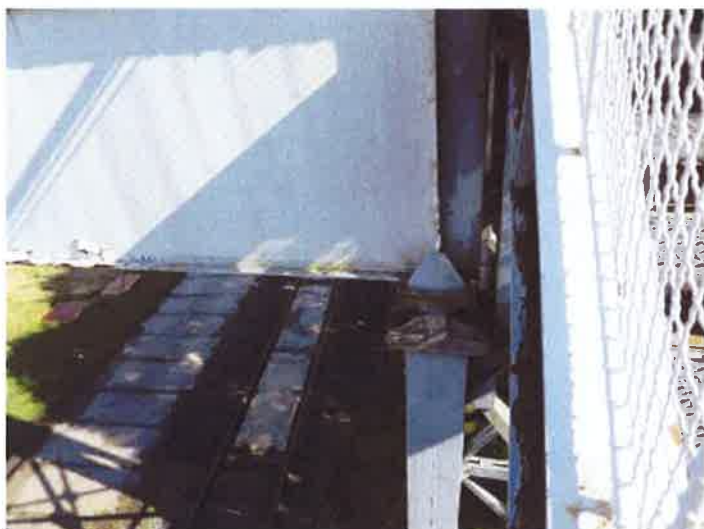
2. východní část NK - uložení NK na pevné ložisko u východního schodiště
