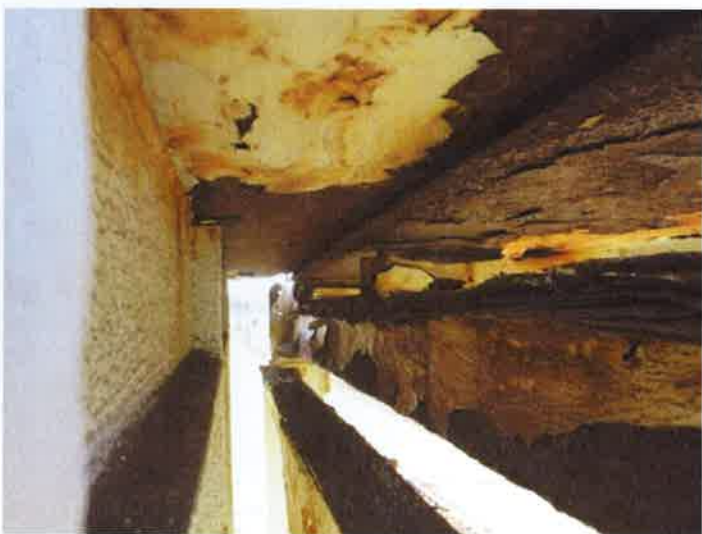
stav konstrukcí v místě napojení 1. části (vlevo) a 2. části (vpravo)
