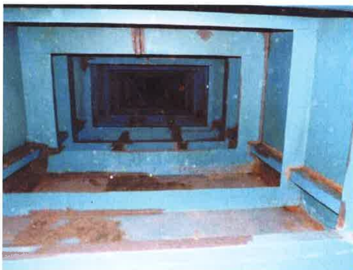
2. východní část NK - průhled otvorem komorového průřezu
