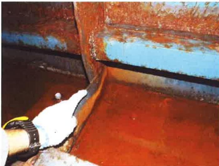
DTTO - deformace prvků ztužení
