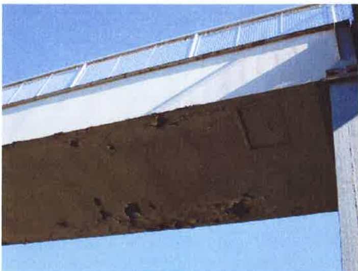
2. východní část NK - pohled NK u východního schodiště
