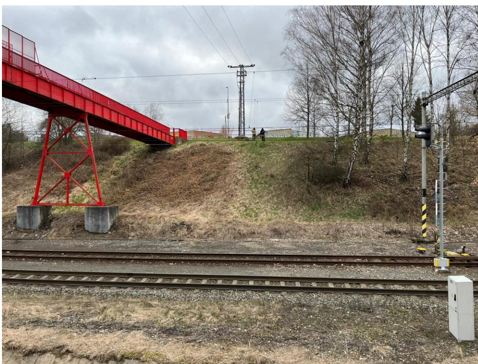
Obr.5 Pohled na levý bok zářezu (ve směru do města)
