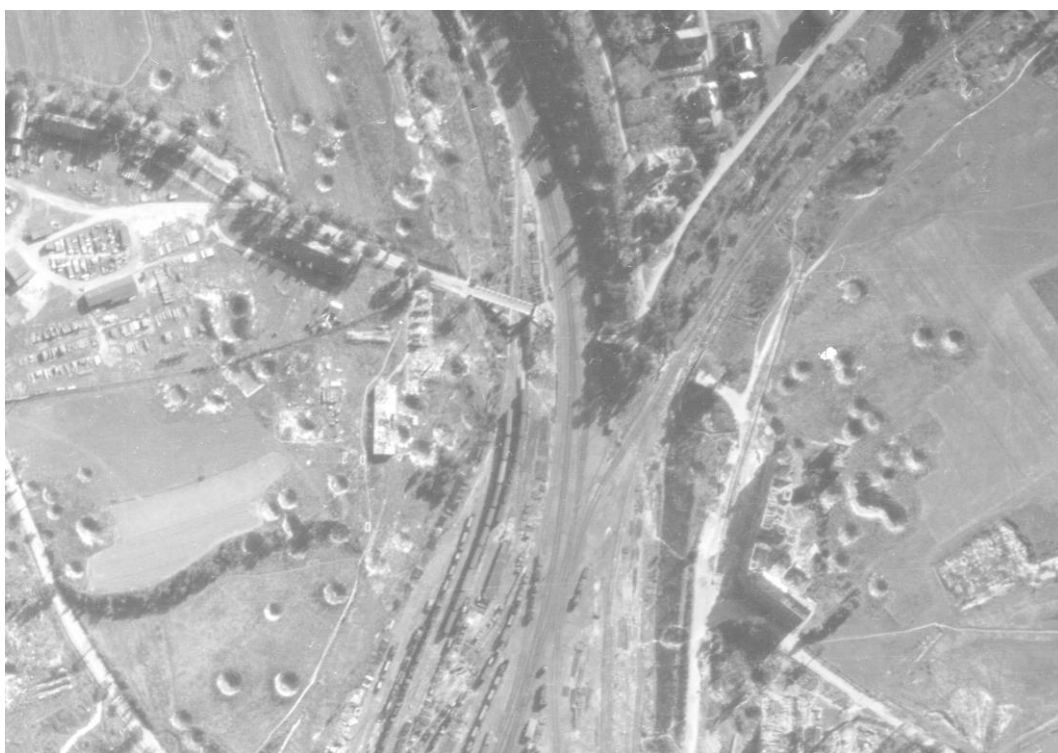
Obr.3 Pohled na most a okolí z leteckého snímku z r. 1946
