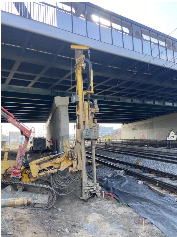
Obr.8 Vrtání průzkumných pilot podél provozované koleje.
