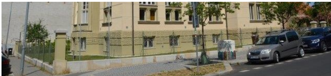
Obr.: Rastr nádechových a výdechových otvorů pro ventilační přizdívku suterénu je viditelný v soklové části fasády.
