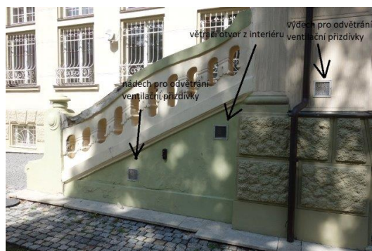
Obr. dole: Kromě mřížek kryjících nádechové a výdechové otvory se na fasádě nacházejí také mřížky, kryjící otvory pro větrání interiéru.
